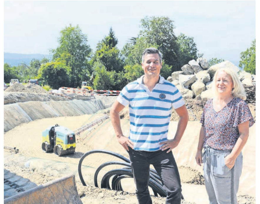
Sie sind zufrieden mit dem Fortgang der Arbeiten: Gemeinderätin Louisa Springer und Martin Graf, Leiter Abteilung Bau und Planung.
