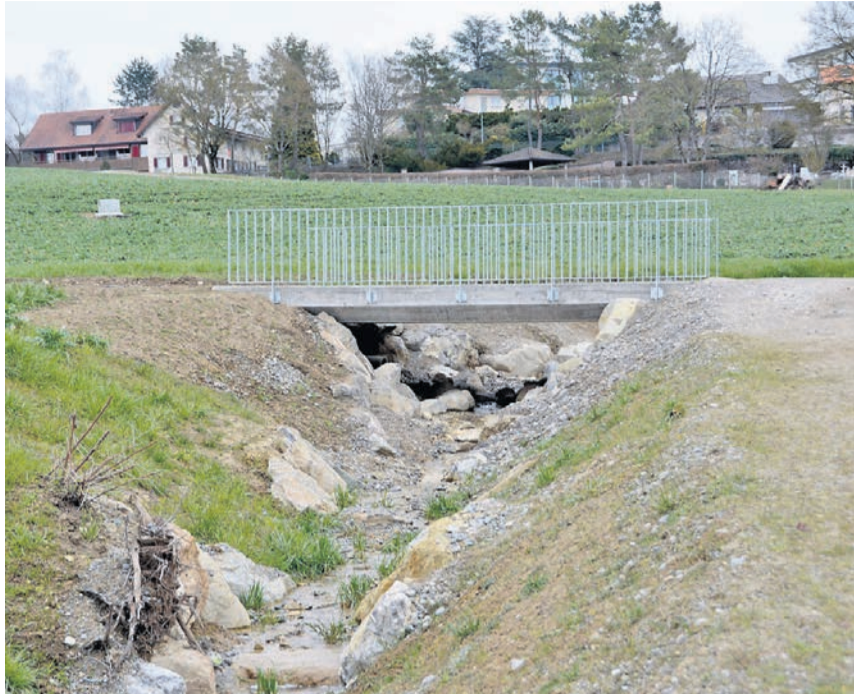
Unterhalb der neuen Brücke für den Kürzihofweg wurde bereits angesät. Noch fehlt die Bestockung mit einheimischen Sträuchern.
